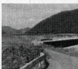
被災した小田川。仮設護岸の矢板が整備されている
