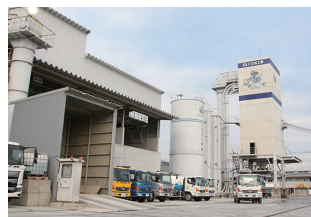
倉敷真備工場
